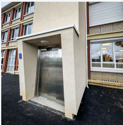
Ascenseur de l'école Jules Ferry
