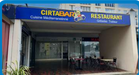
CIRTA Restaurant-Traiteur Plein Sud, rue André Maurois
